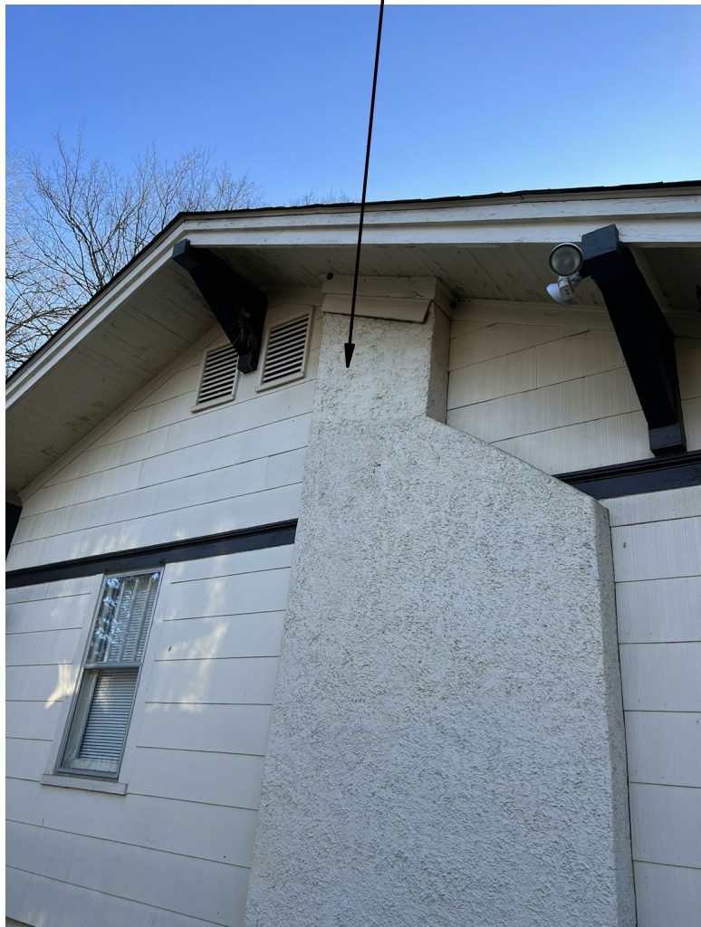
LEFT SIDE CHIMNEY
