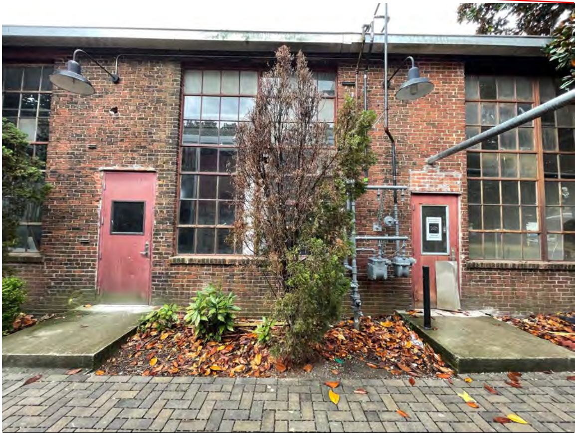
EXISTING DOORS AT TENANT SUITES 11DD & 11FF
