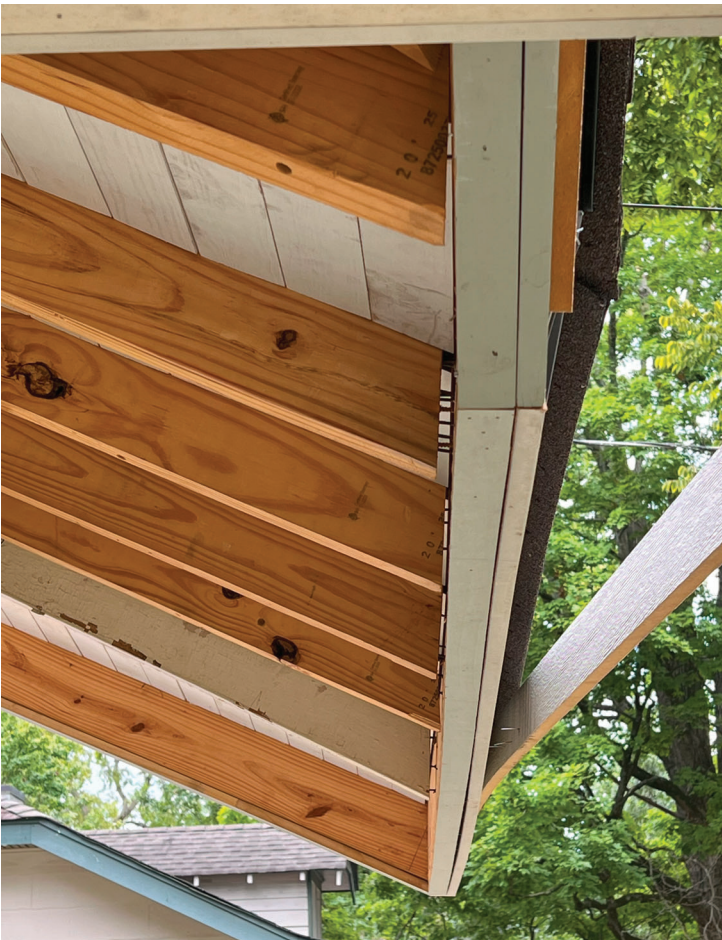
FRONT EAVE OUTER EDGE
