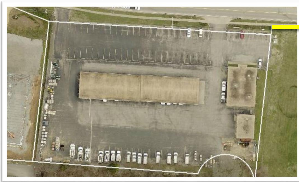
Liberty Pike- ATT Parking Lot
